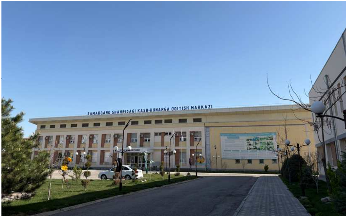
▲ 우즈베키스탄 사마르칸트 직업기술훈련원(현 사마르칸트 제4테크니쿰) 전경
